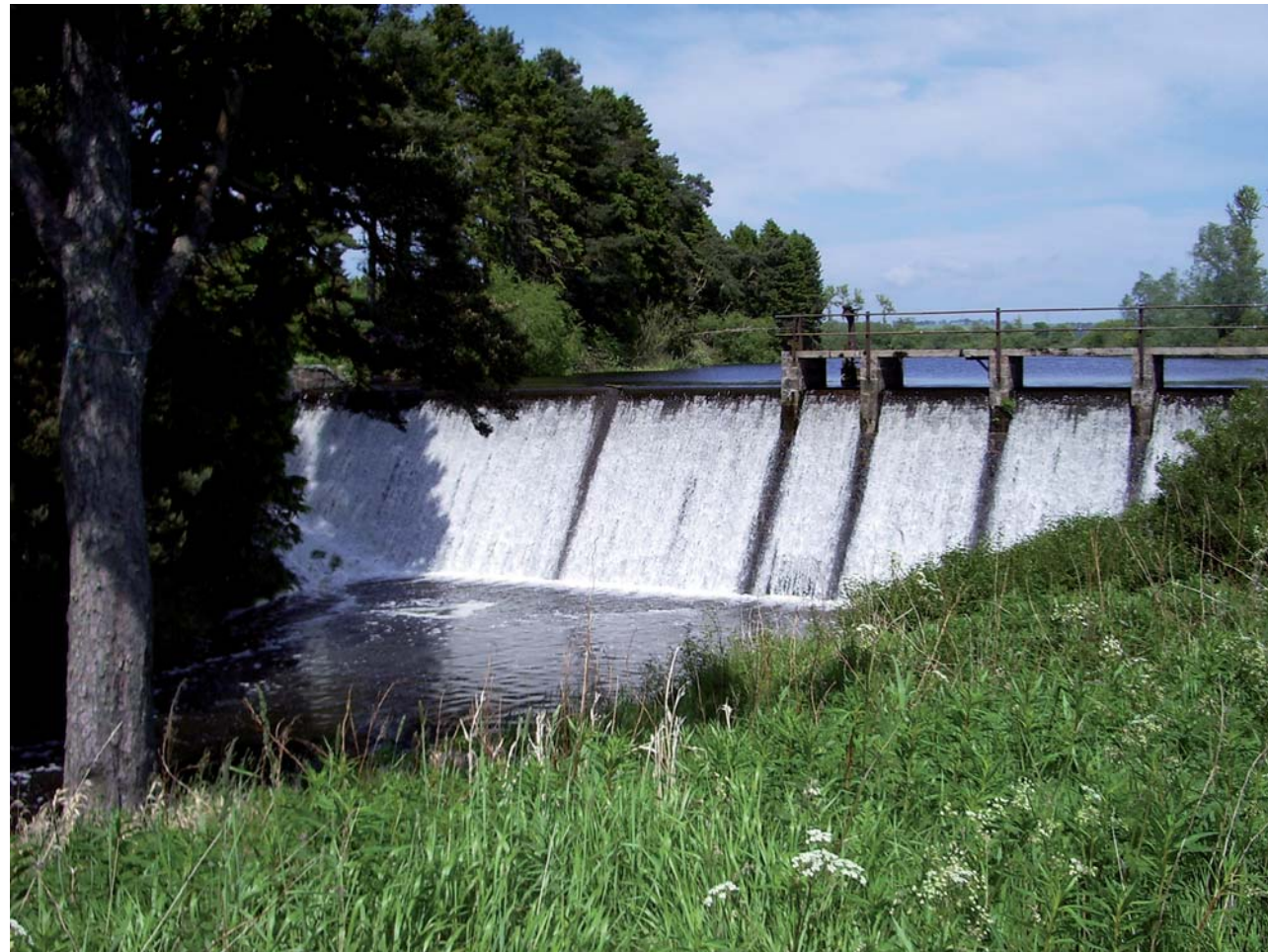
Garlogie Dam (DDSF)
